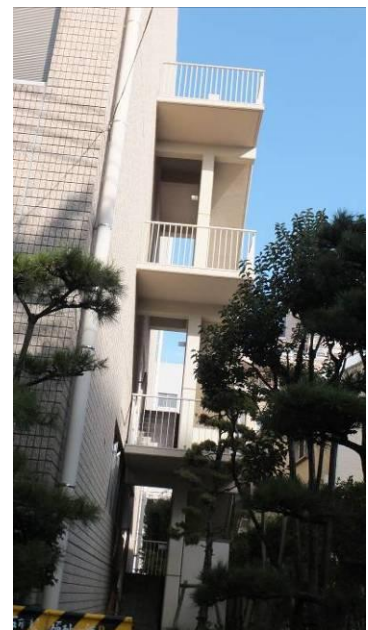
建物東側非常階段
