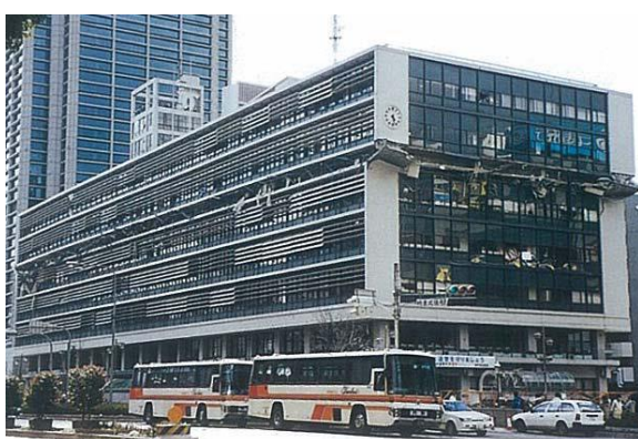
図2-2 兵庫県南部地震における神戸市役所の庁舎被害
