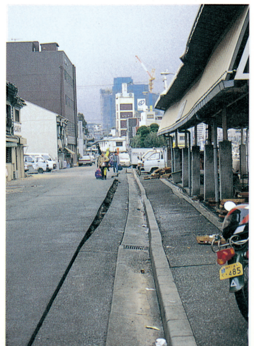
亀裂が入り段差ができた道路(本町1丁目)
