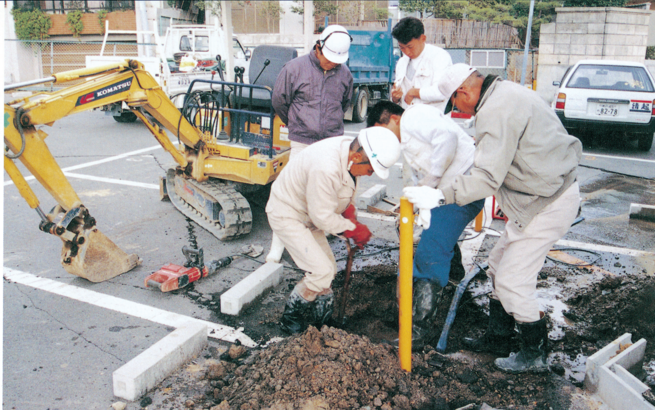
早期復旧をめざして24時間態勢で緊急修繕にあたった(東人丸町)
