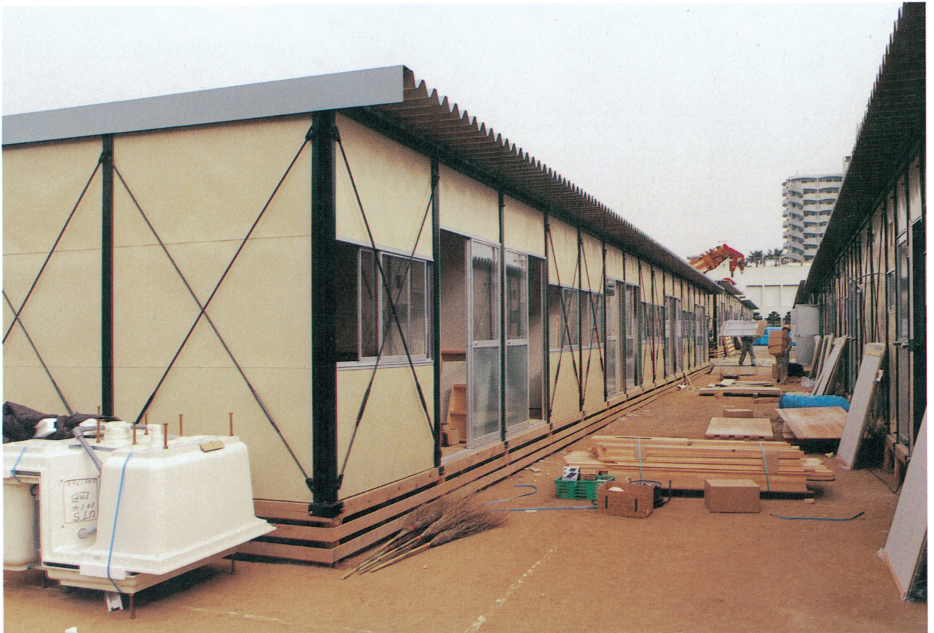
市内にも13か所、856戸の仮設住宅が建設された(中崎1丁目)
