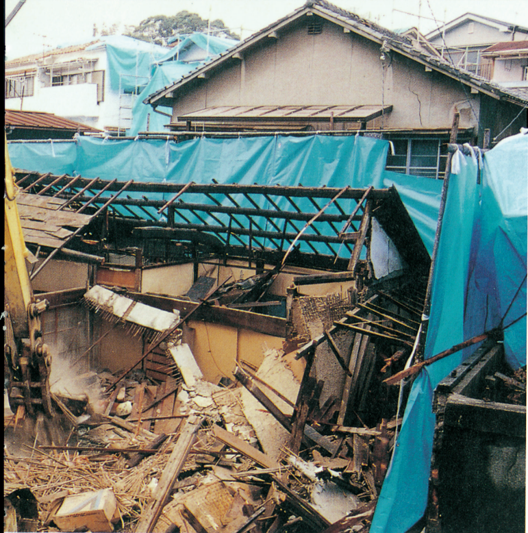
市内でも2,000棟以上の家屋が解体された(太寺3丁目)
