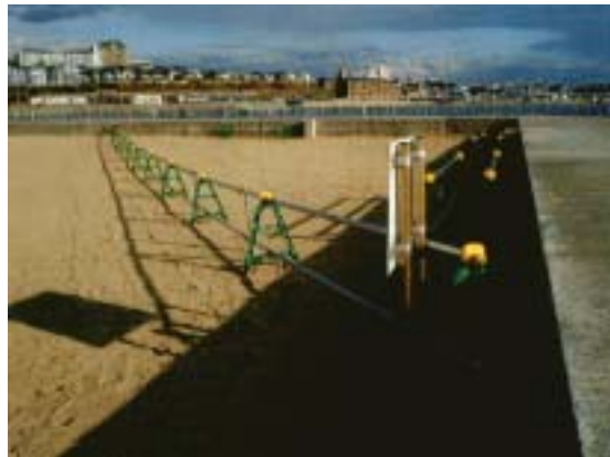
バリケード設置状況
