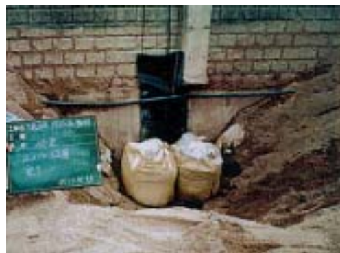
新防砂板を貼付けトン袋で押さえた様子
