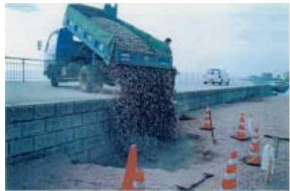
単粒砕石による埋め戻し作業
