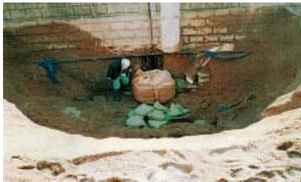
[ケーソン 8 - 9] 防砂板をトン袋で押さえた様子
