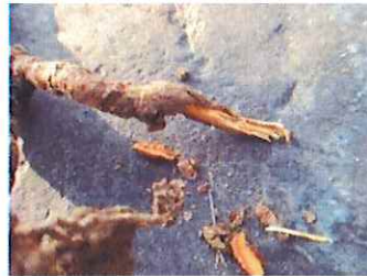
先端部も腐朽、崩壊
