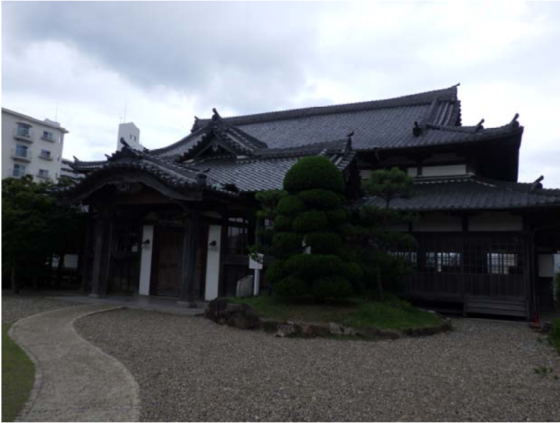
中崎公会堂全景
