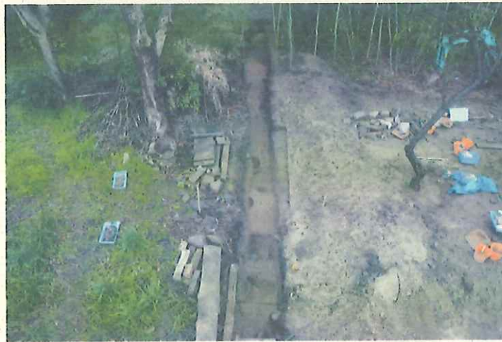
2区 第2遺構面完掘状況全景 (西から撮影)
