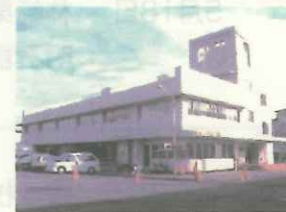
藤江公設卸売市場 (昭和52年開設)
