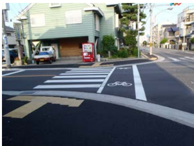
【歩道の段差解消】
