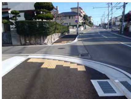
【段差解消グレーチングの設置】
