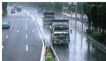
左：排水性舗装 右：通常の舗装
