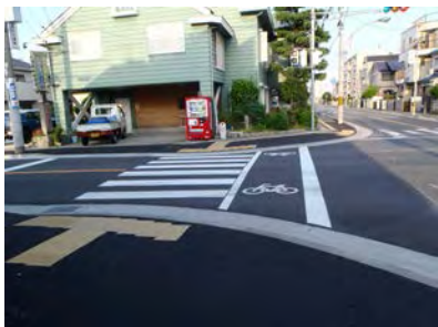
【歩道の段差解消】
