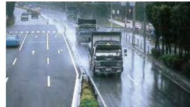
左：排水性舗装 右：通常の舗装
