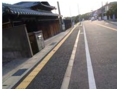
【歩道の傾き解消】
