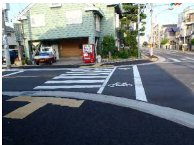
【歩道の段差解消】
