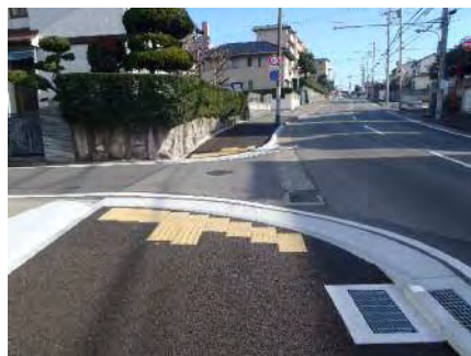
【段差解消グレーチングの設置】
