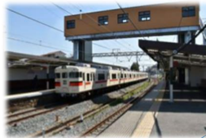
駅舎バリアフリー (山電林崎松江海岸駅)
