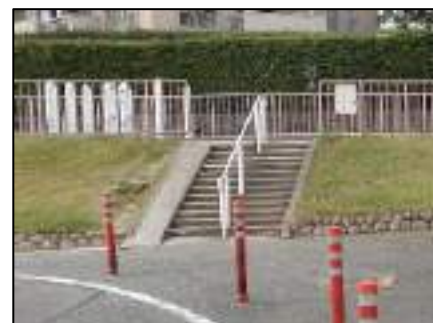
階段に手すりとカート用スロープを設置
