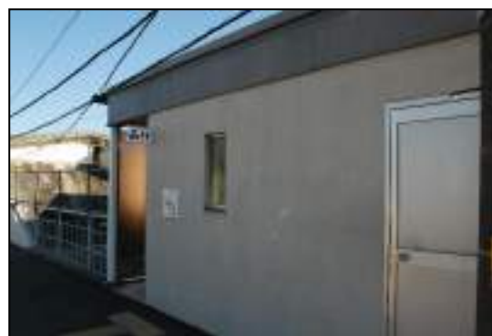
駅構内の多目的トイレ
