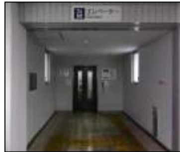
東口連絡通路のエレベーター
