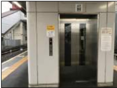
駅構内のエレベーター
