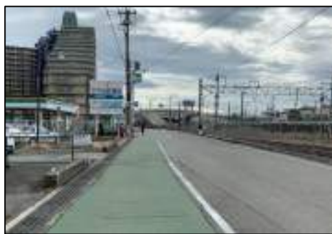
路側帯のカラー舗装(駅北側)
