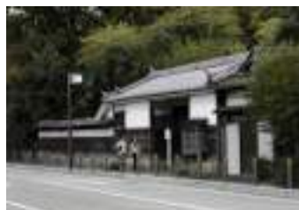
市指定建造物 織田家長屋門
