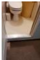
トイレの段差
