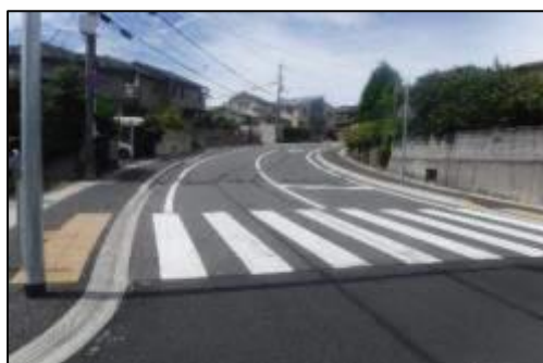
歩道の波打ち解消・段差の改修
