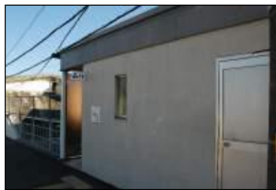
駅構内の多目的トイレ
