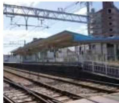
駅構内のスロープ
