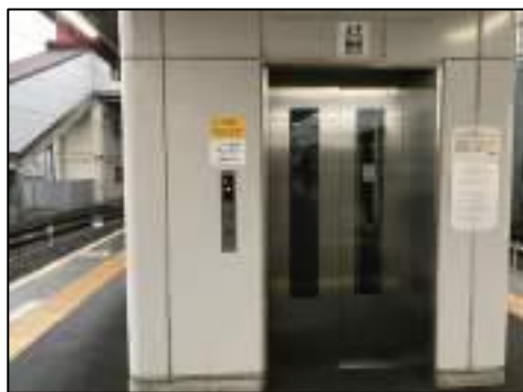
駅構内のエレベーター
