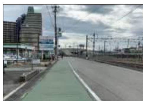
路側帯のカラー舗装(駅北側)
