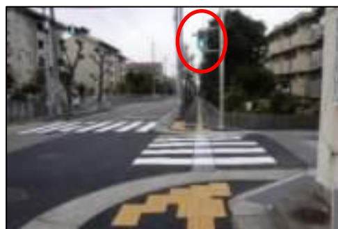
音響式信号機の設置
