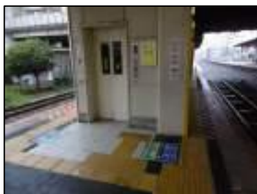
駅構内のエレベーター
