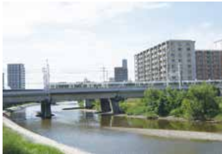
いよいよ始まる改修工事
