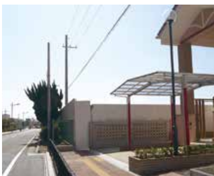
土地取得に伴い東側の歩道も整備
