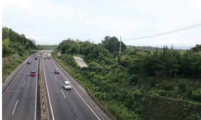
神戸西バイパス延伸工によりアクセス道路を整備
