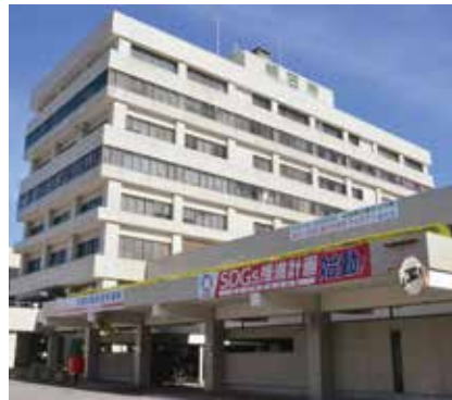
老朽化が進む現庁舎
