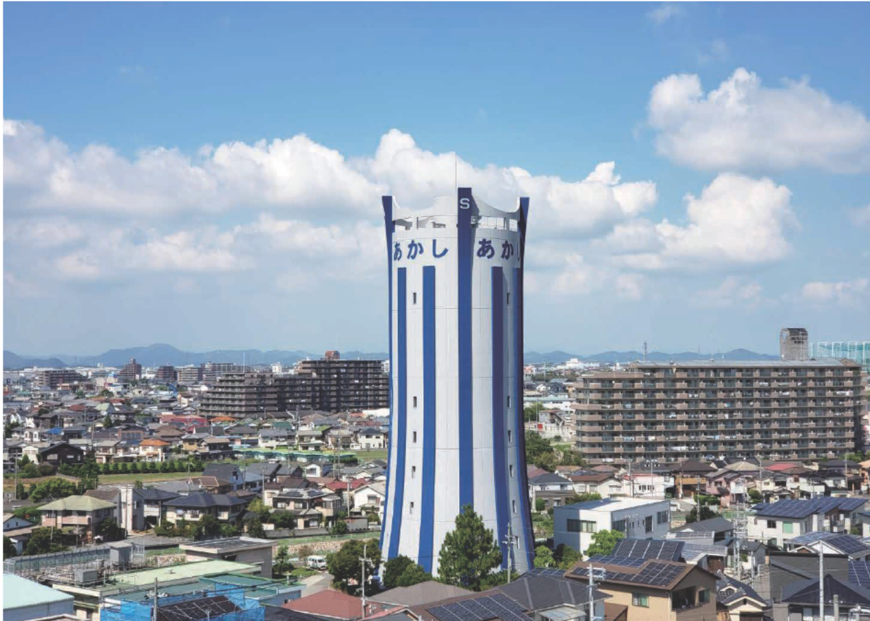
安全・安心な水を市民に供給(魚住浄水場・配水塔)
