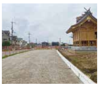
整備中の山手環状線大窪工区
