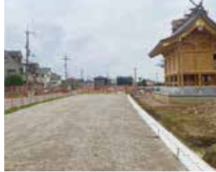
整備中の山手環状線大窪工区
