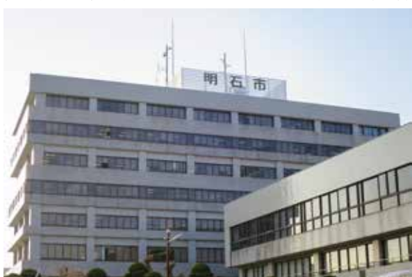
建て替えを控える市庁舎
