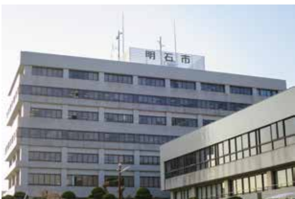
建て替えを控える市庁舎
