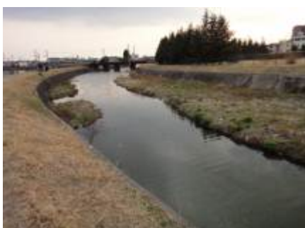
1 5 碓永自動車(株)前 堰堤
