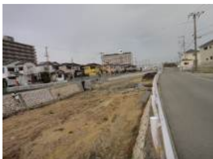
1 8 魚住浄水場入口前 堰堤
