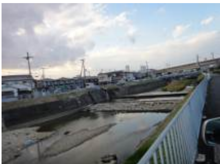
9 魚住町西岡西見里付近 堰堤
