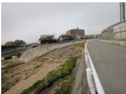
1 7 魚住浄水場前 堰堤
