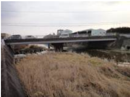
3 県道 718 線（八幡橋）付近
