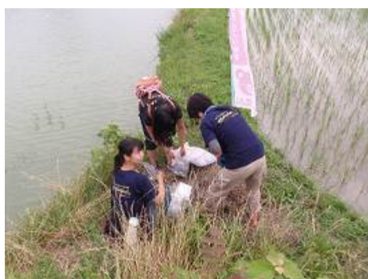
作業員と実習生による防除作業の様子 (7月5日 瀬戸川)
