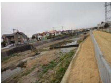
1 2 内外ゴム本社工場前 堰堤
