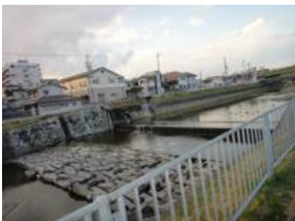
7 魚住町住吉 4 丁目付近 堰堤
