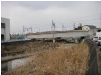
4 山陽電鉄本線下付近
