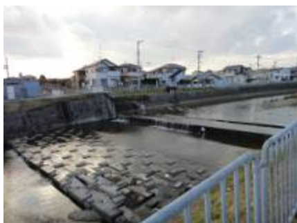
6 魚住町住吉 4 丁目付近 堰堤
