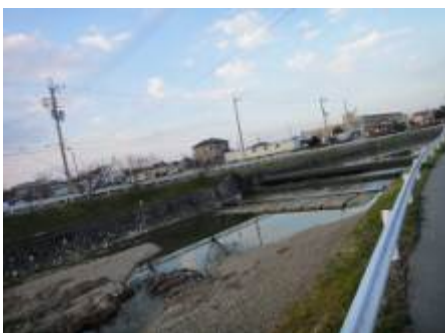
21 魚住町清水付近 堰堤
