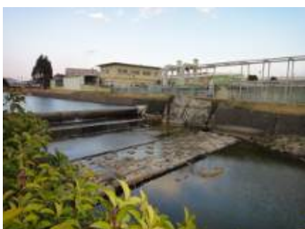
1 3 二見町東二見付近 堰堤
