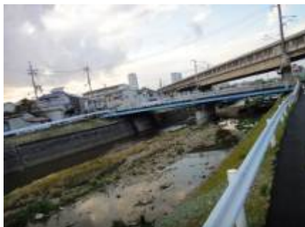
10 山陽新幹線下（山川橋）付近
