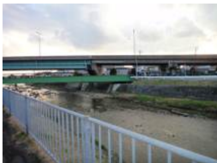
8 国道 250 線下（大見橋）付近
