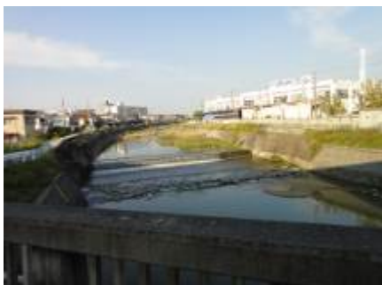
1 1 内外ゴム本社工場前 堰堤
