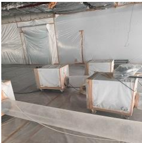
アスベスト除去作業現場
