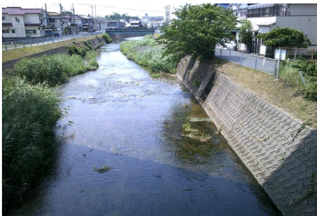
谷八木川測定地点(谷八木橋下流)
