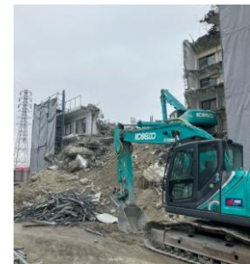
解体工事現場
