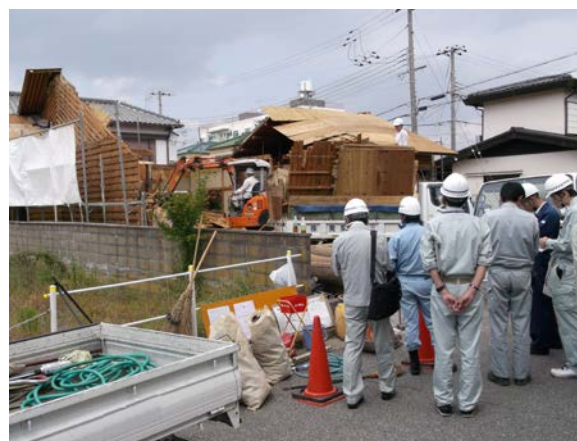
写真 4-5 解体現場における規制・指導
