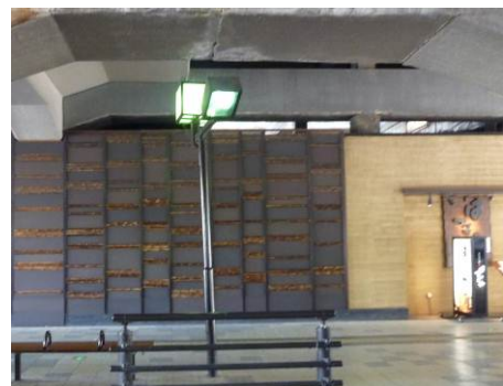
図 4-3 明石駅東側ガード下の照明 LED 化
