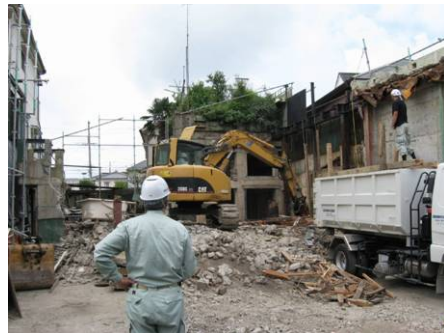
図 4-24 解体現場のパトロール
