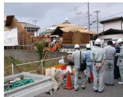
解体現場の立入調査
