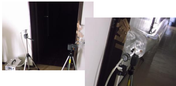
アスベスト調査
