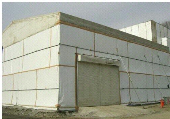
図 建物全体の隔離養生（例）
