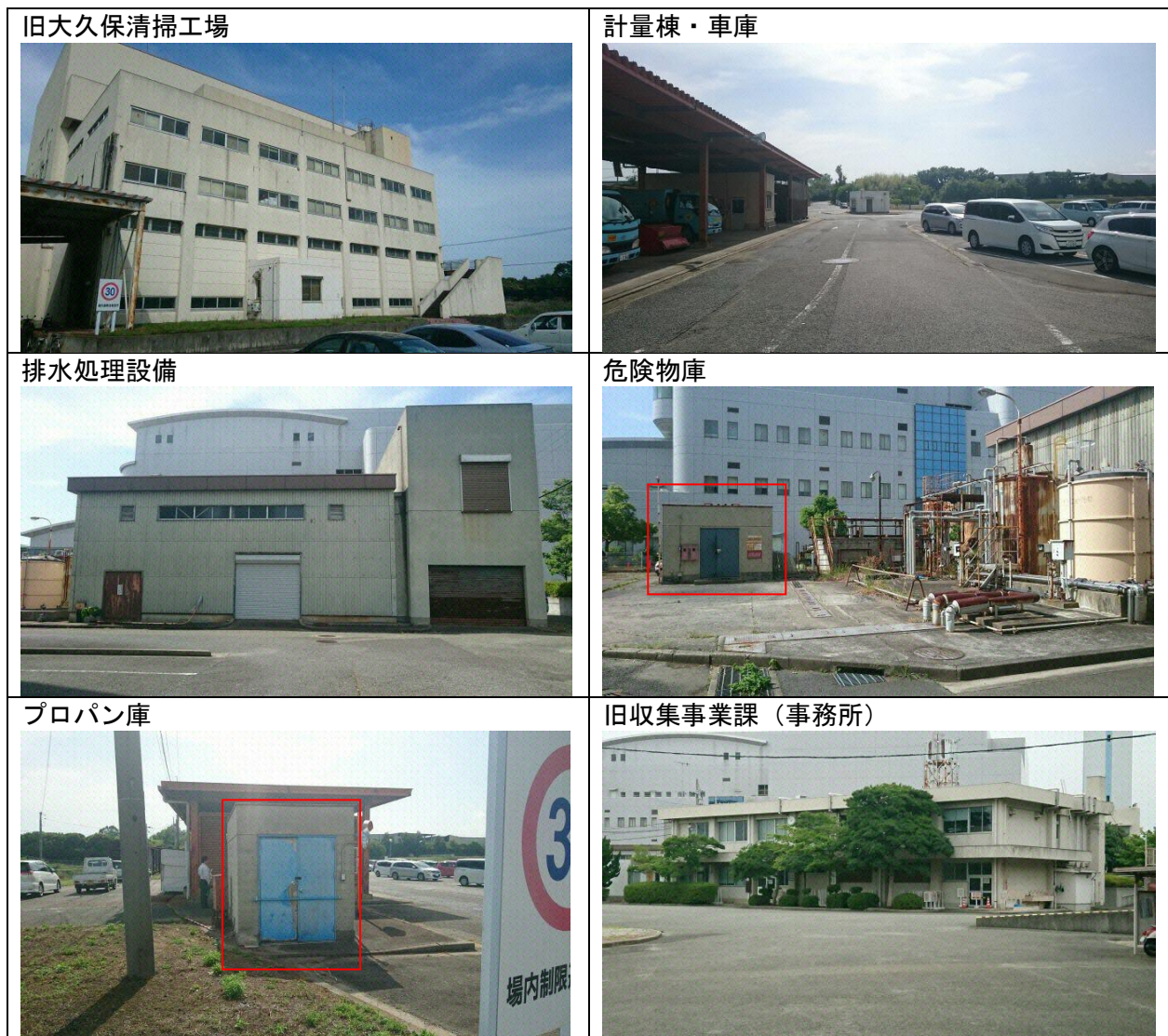
図 代表的な解体建築物
