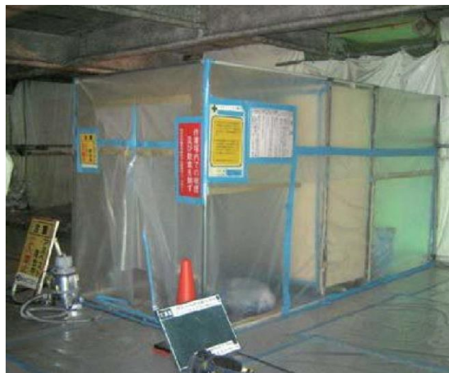
図 セキュリティールーム出入口外観（例）
