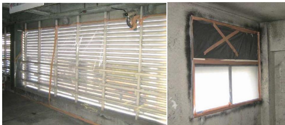
図 外壁開口部や窓の隔離養生（例）
