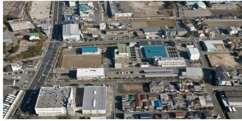
明石川浄水場
