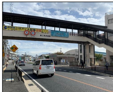
駅南のデッキ通路
