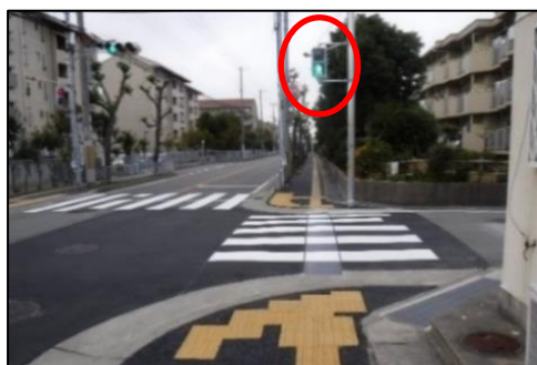
音響式信号機の設置
