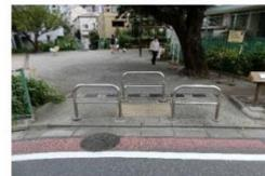
【複数配置】車止めの配置の仕方によっては、車椅子が通行できない
