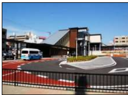
エレベーター・エスカレーターの整備
