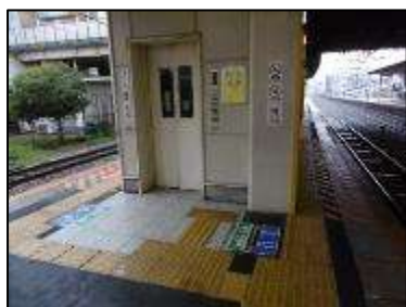
駅構内のエレベーター
