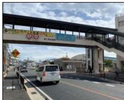
駅南のデッキ通路
