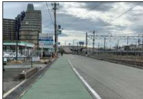
路側帯のカラー舗装(駅北側)
