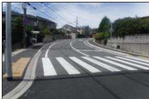
歩道の波打ち解消・段差の緩和
