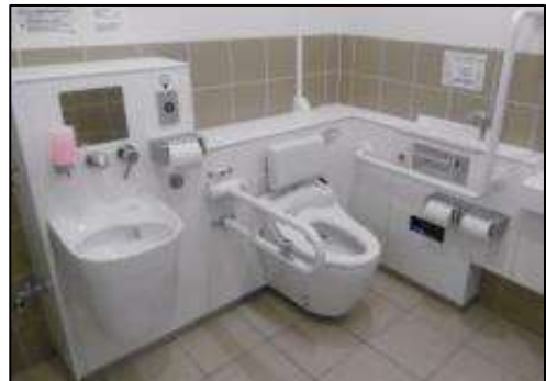
公園内の多目的トイレ(明石公園)
