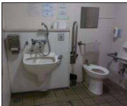
駅構内の多目的トイレ
