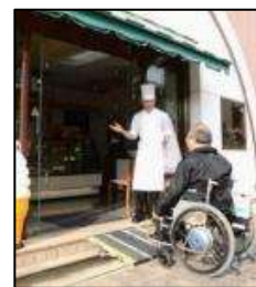
制度を活用したスロープの設置
