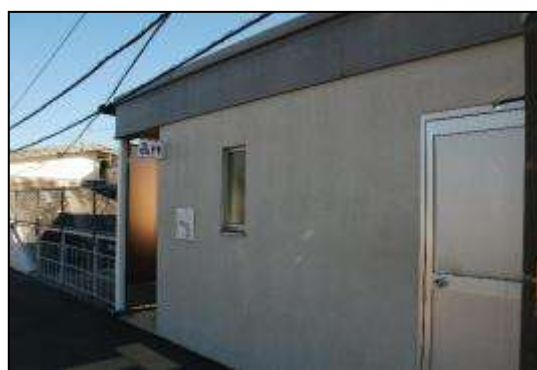
駅構内の多目的トイレ
