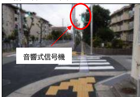
音響式信号機の設置
