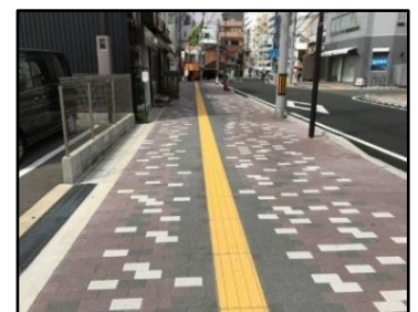
(視覚障害者誘導用ブロック)
