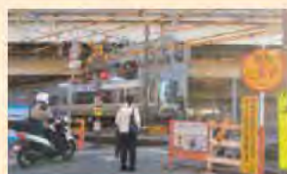
歩道橋の完成後は踏切を閉鎖します
