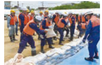
▲土のうを使った水防工法
