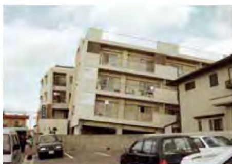
柱が折れ、大きく傾いたマンション
