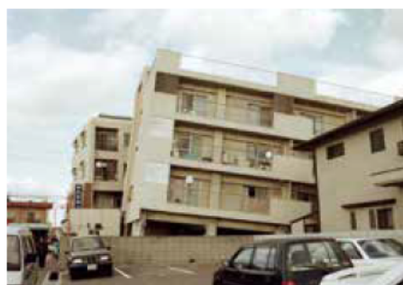
柱が折れ、大きく傾いたマンション
