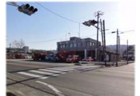
「活動の拠点となった山元分署」（敷地内のひび割れも多数残っていた）
