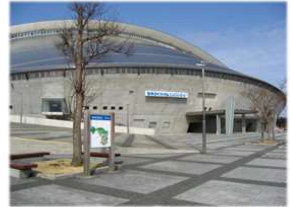
「宮城県総合体育館（遺体安置所にも指定されていた）」
