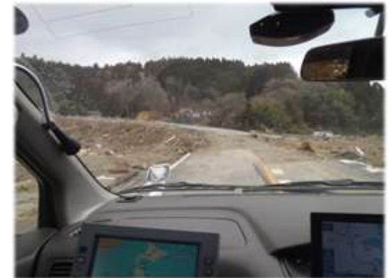
「道路はいたるところで陥没し崩れ落ちている」
