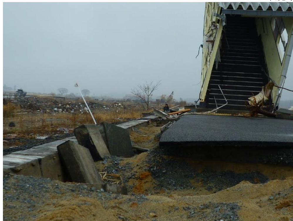
ホームが、えぐりとられ、跨線橋とコンクリート造の公衆トイレ以外は流失、津波のすさまじさがうかがえる。
