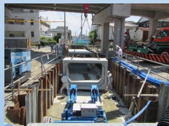
雨水BOXカルバート工事状況
