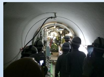
トンネル掘削機内の見学状況
