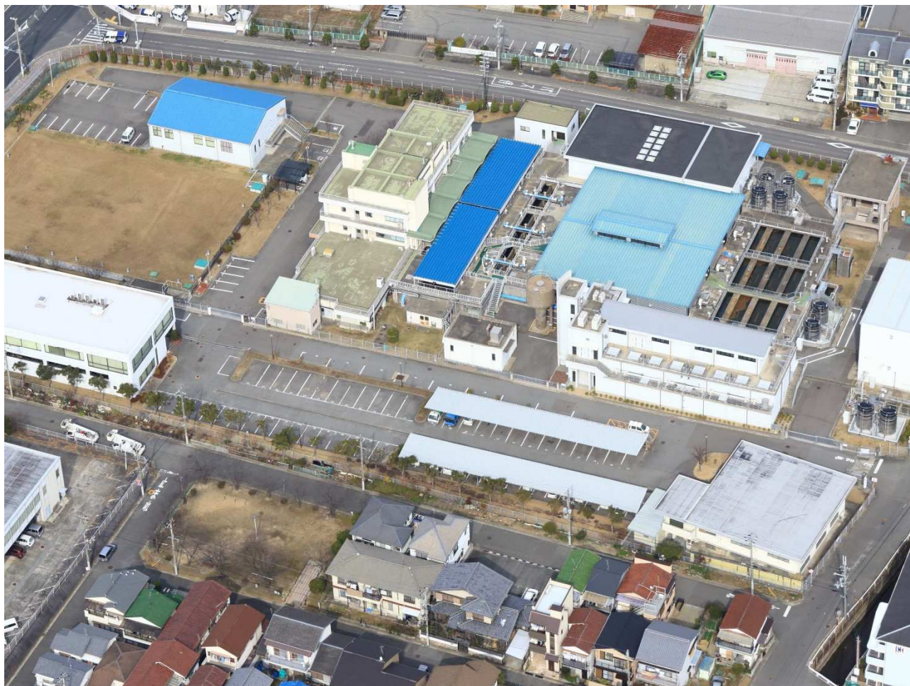
明石川浄水場
