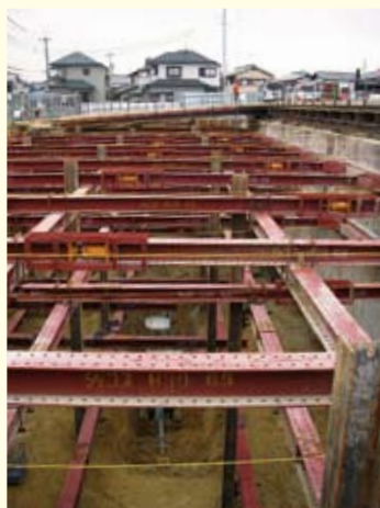
▲建設中の鳥羽浄水場 高度浄水処理施設
