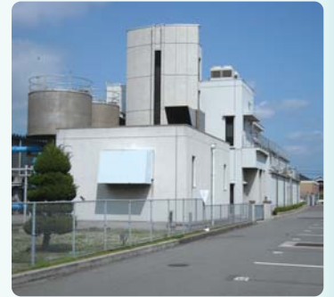
明石川浄水場高度浄水処理施設
