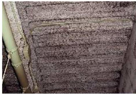
(柱・梁・天井等に吹付けられたアスベストの例)
