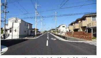
山手環状線道路整備
