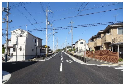
都市計画道路 山手環状線(西工区)
